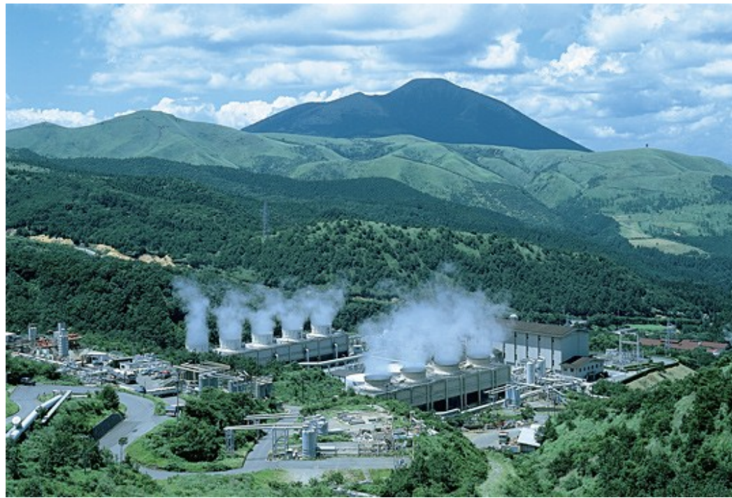
大分県八丁原地熱発電所(出力 110,000kW)
