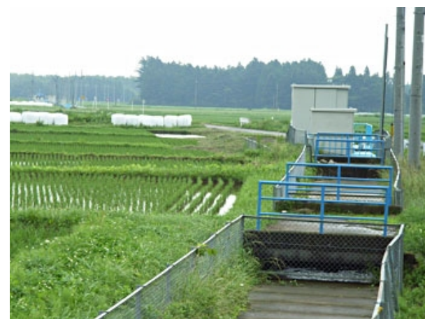
百村第一発電所
