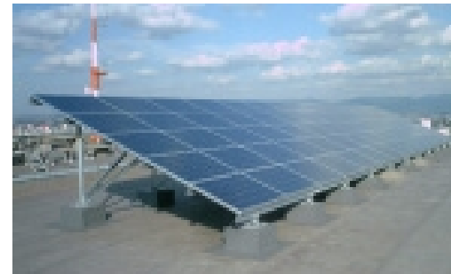
福岡市本庁舎屋上
