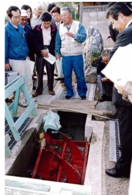
川上水力発電所
