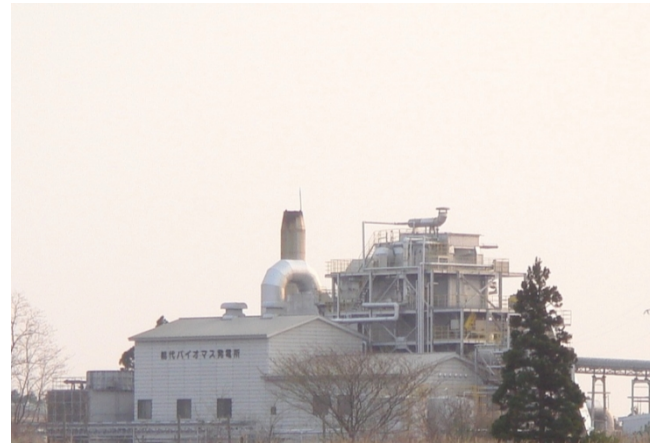
能代バイオ発電所
