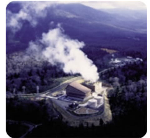
澄川地熱発電所
