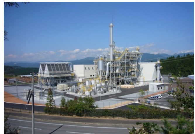
日田ウッドパワー日田発電所
