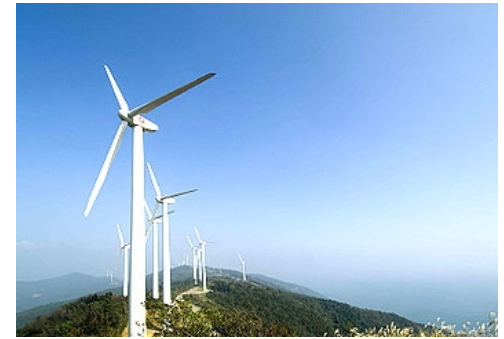
佐多岬風力発電所
